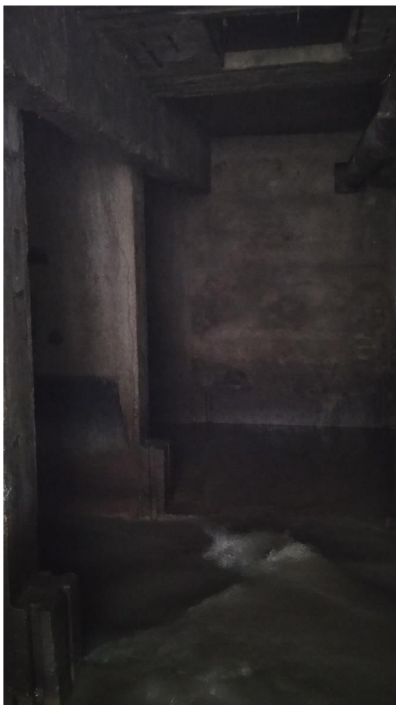
Obrázek 7: Přerušení tvaru krytého profilu v místě vstupu, pohled na zadní stěnu. Foto z 9. 3. 2023
