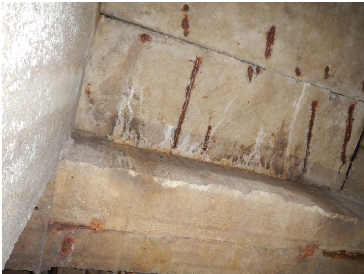
Obrázek 11: Desky stropu střední chodby spolu s trámem vstupu. Na snímku je patrná odhalená a korodující výztuž konstrukcí. Foto z 4. 8. 2023
