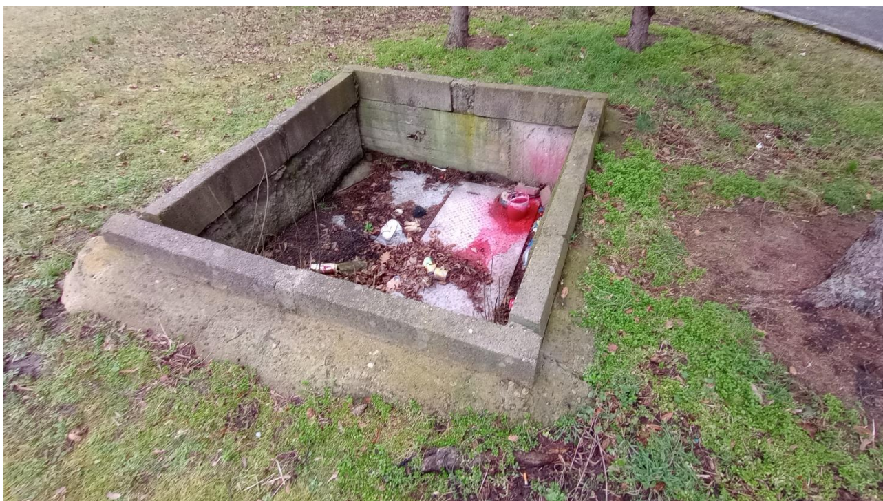
Obrázek 3: Další ze vstupů. U tohoto je vidět dodatečné navýšení terénu po výstavbě panelových domů v ulici Pražská („Malá Pražská“). V rámci obnovy bude vstup vynesena na povrch a opět zajištěn uzamykatelnými poklopy a novým zábradlím. Foto z 14. 2. 2023
