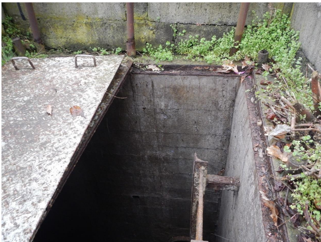
Obrázek 9: Detail vstupu s otevřeným poklopem. Poklopy se vymění za zamykatelné, žebříky nahradí za nové nerezové, vstup se vynese na povrch a zabezpečí zábradlím. Foto z 17. 4. 2023
