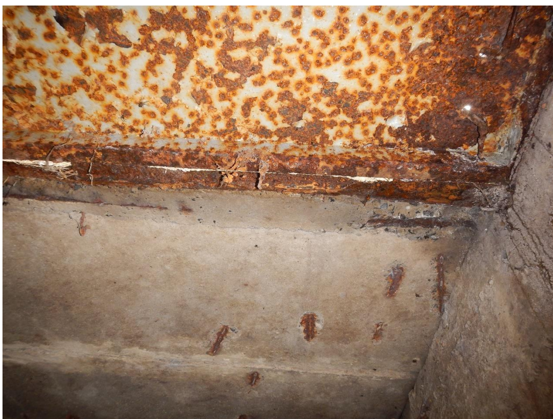
Obrázek 10: Detail plechu poklopu vstupu z vnitřní strany v místě navázání na stropní panely vstupu. Foto z 4. 8. 2023
