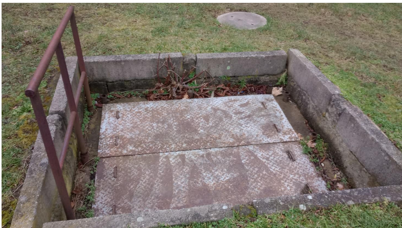
Obrázek 2: Jeden ze vstupů do profilu. Současné poklopy budou vyměněny za uzamykatelné a vstup bude opatřen novým zábradlím. Foto ze 14. 2. 2023
