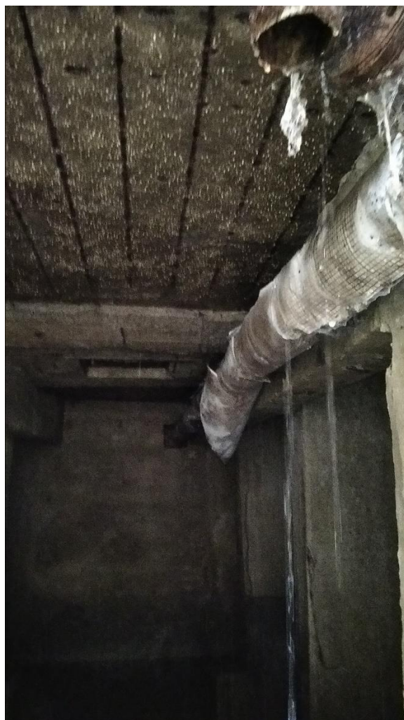
Obrázek 8: Prostor vstupu č. 4. Na snímku je vidět provedení vodovodu LT 100 napříč profilem podél příčného stropního trámu vstupu. Foto z 9. 3. 2023
